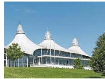
Das Badehaus in Masserberg muss nach rund 20 Jahren Betrieb saniert werden. Foto: Thüringen Tourismus
